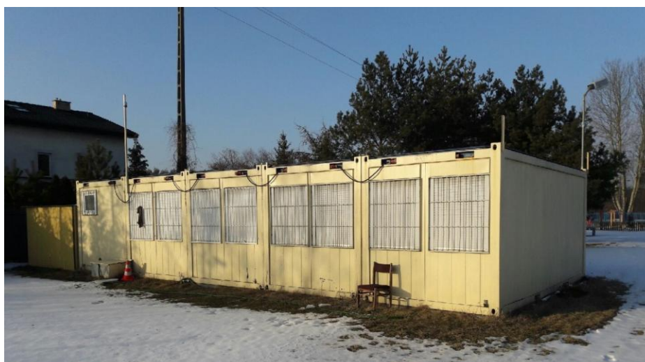
Fotografia 12. Świetlica wiejska w Suchocinie.
