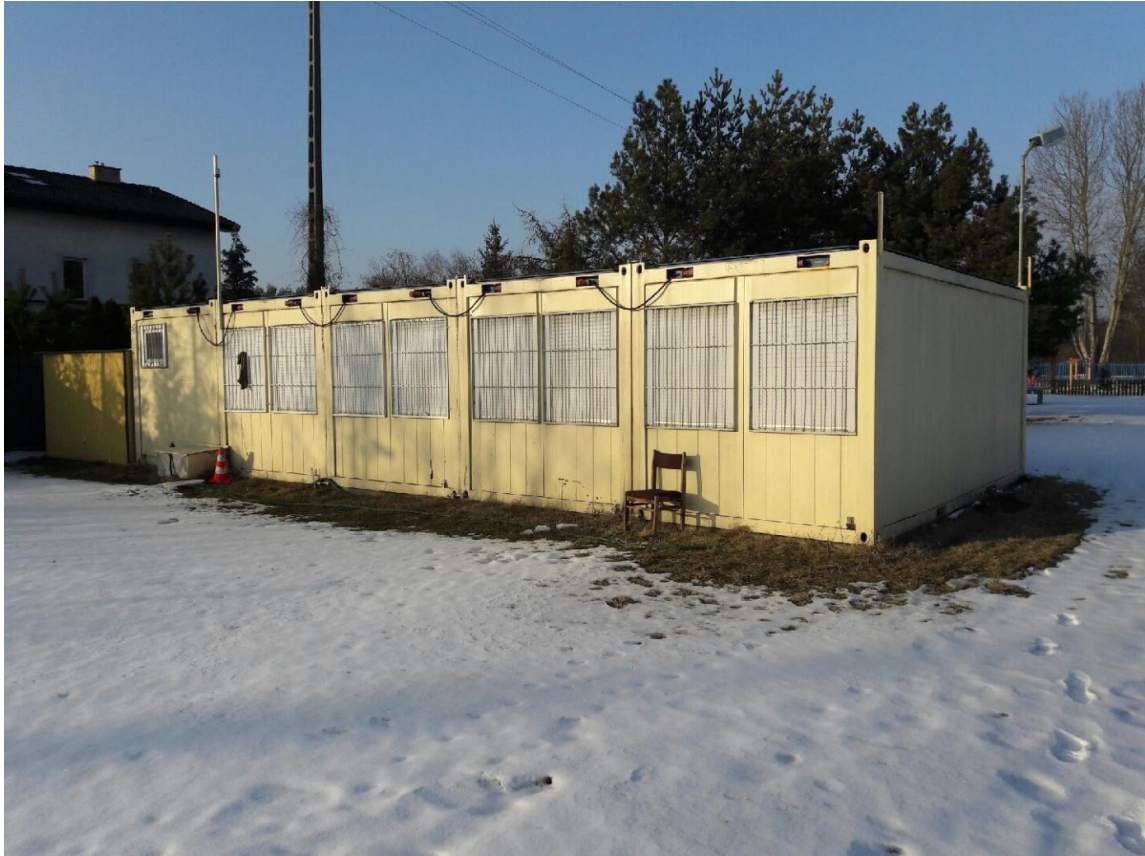
Fotografia 3. Świetlica wiejska w Suchocinie.
